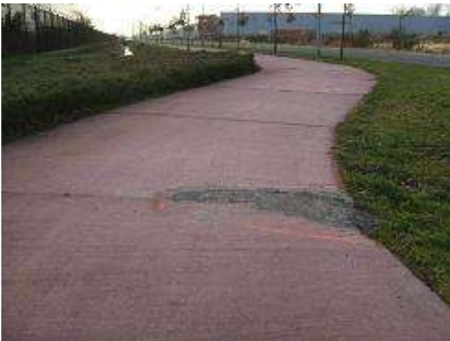
Afbrokkelend fietspad hersteld.
